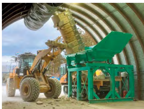
図二 自動化ホイールローダのずり投入状況
