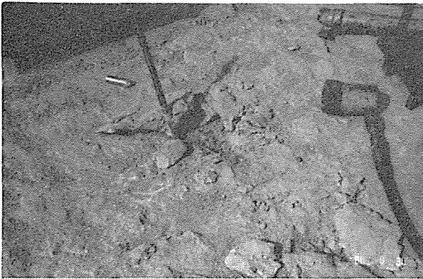
Photo-4 土間コンクリートが破壊した状況
