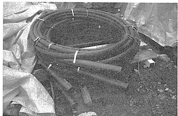
Photo-3 アンカー引張材 SEEE F-200 SEEE F-200 cable
