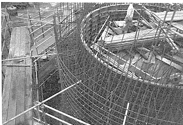
Photo-6 構築状況 Construction
