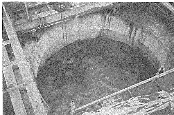
Photo-5 掘削状況(掘削深度-2.5m) 载荷と併行して掘削できる。 Excavation (depth -2.5m)
