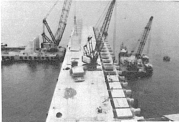
Photo-4 プレキャストスラブ据付 Precast beam placing
