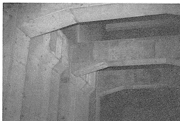
Photo-5 コンクリートの打上り状況 Architectural concrete finish of girder and column
