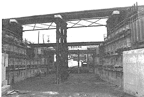
Photo-1 福島～東福島間矢野目こ道橋新設工事 (最終床付面まで掘削完了時)
