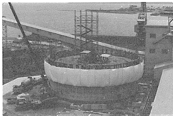
Photo-1 スライディング工事全景
