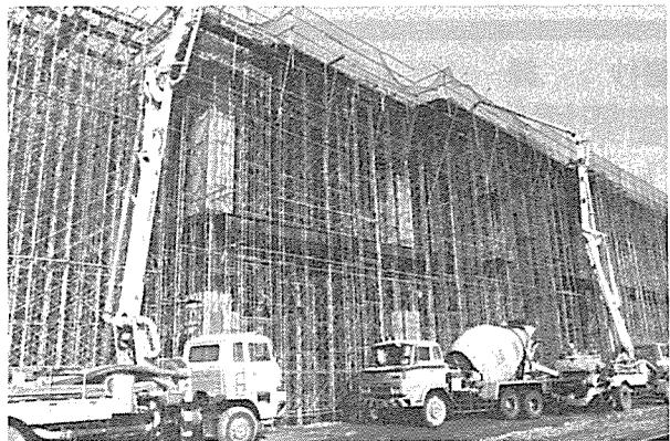
Photo-2 軌道階(最上階)施工中のSRC2層ラーメン式高架橋(1層スラブ未施工のため支保工は基礎からの総ビティイとなった)
