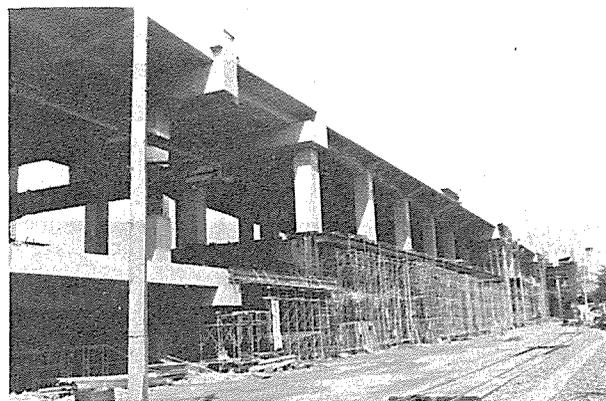
Photo-3 軌道階完成後、中層階施工中のSRC2層ラーメン式高架橋
