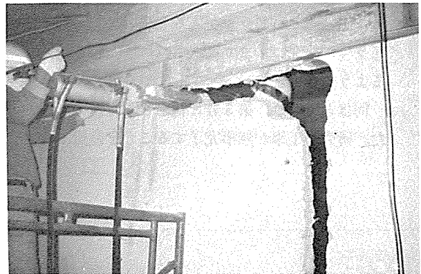
Photo-4 ウォールカッターによる縁切り
