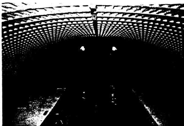
Photo4 覆工コンクリート打設完了
