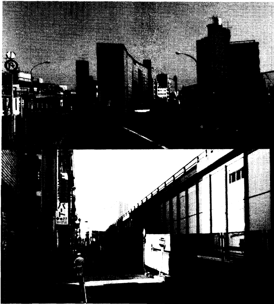
Photo7 作業基地の防音壁
