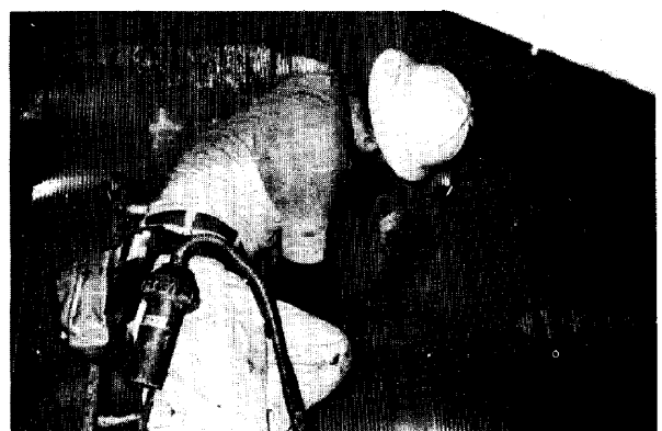
Photo1 防水シート溶着
