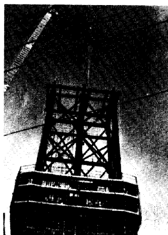
Photo4 形鋼を加工し鉄筋を両面から挟み込む方式としPhoto3の欠陥を改良したが、やや作業効率が劣る。
