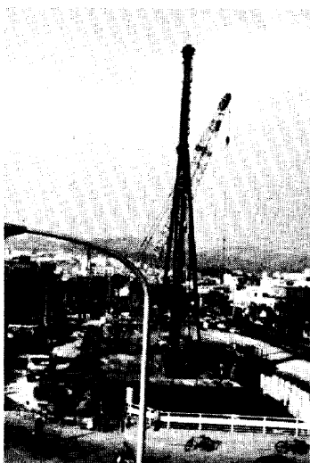
Photo4 棧橋上からの鋼杭打設
