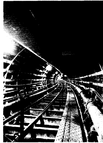
Photo2 一次覆工及び圧送管配管状況
