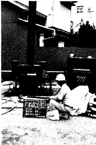
Photo2 H形鋼引抜状況
