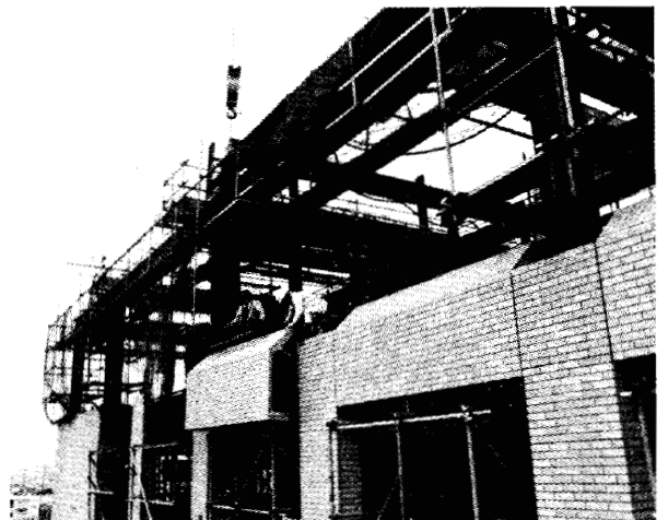
Photo5 オムニア外壁梁型版取付
