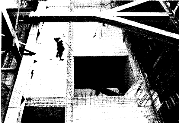
Photo2 B1階床オムニア版取付
