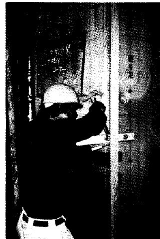
Photo3 出隅部役物れんがの添積み
