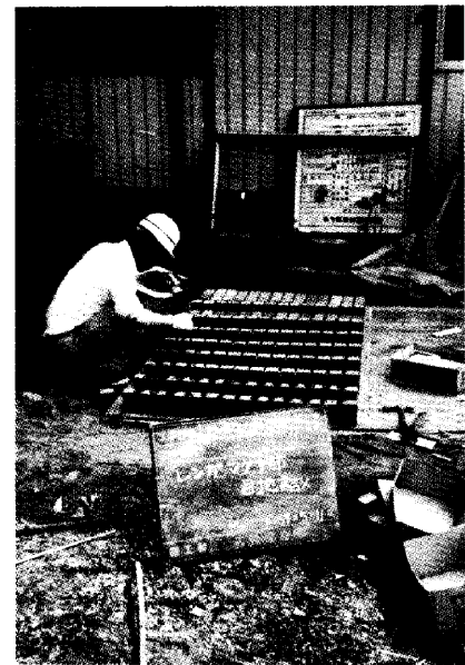
Photo4 楣れんがのPC化作業
