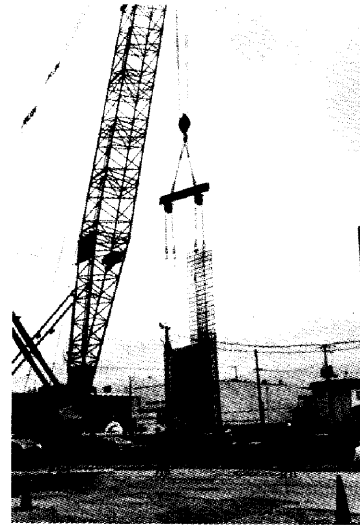
Photo3 鉄筋かご建込
