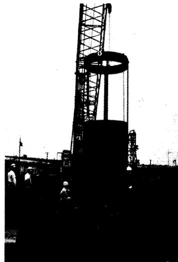
Photo3 防蝕管とヤットコ管との接続
