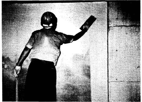
Photo1 木鋺押し作業
