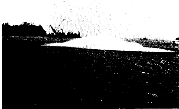
Photo 2 海底発破状況 (第1回発破、薬量480kg)
