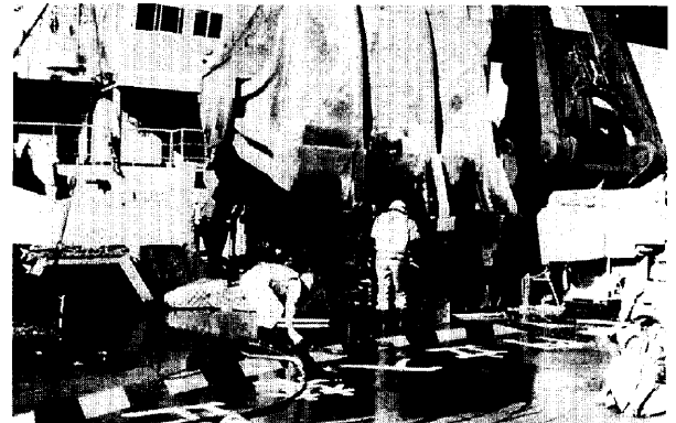
Photo 5 グラブ爪の交換状況
