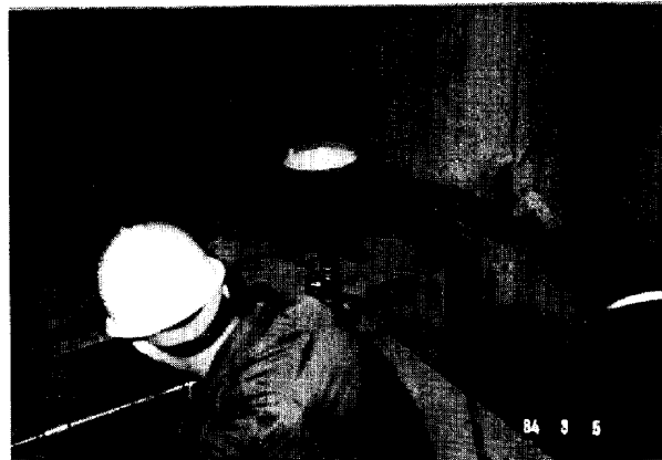
Photo 2 フラットジャッキによるプレローディング状況
