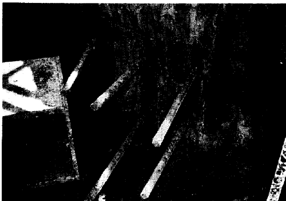
Photo 1 連続地中壁に埋込まれたせん断伝達鉄筋
