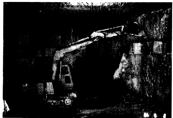
Photo 4 小型ブレードカーによるコーベルの撤去
