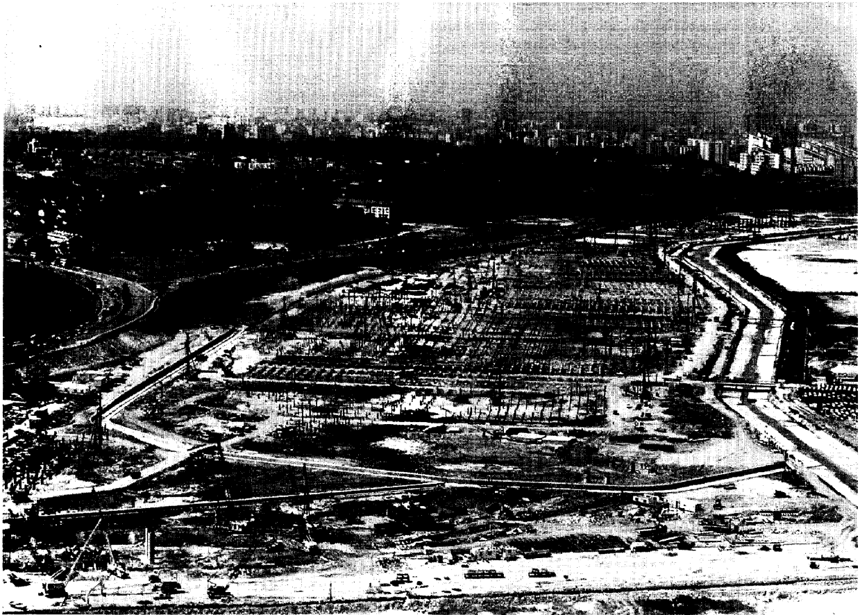
Photo1 工区全景写真(1985年6月3日)
