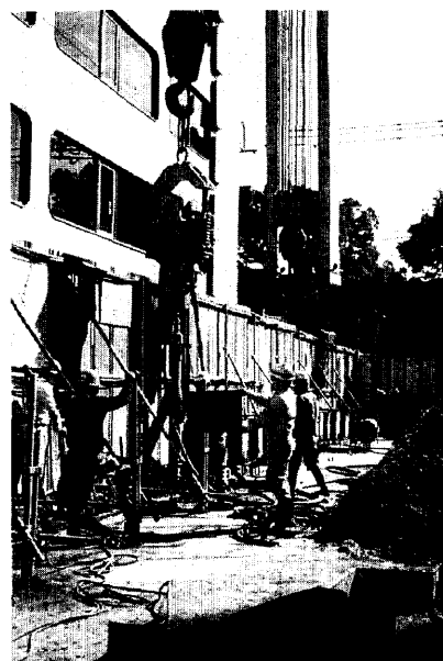
Photo 3 シートパイル引抜跡に注入ロッドを挿入しソイルセメント注入
