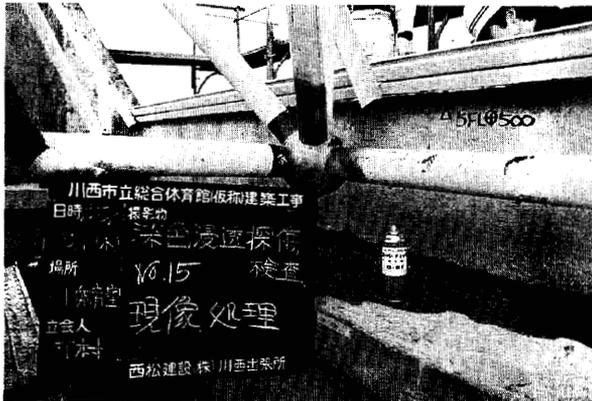
Photo 4 浸透探傷検査
