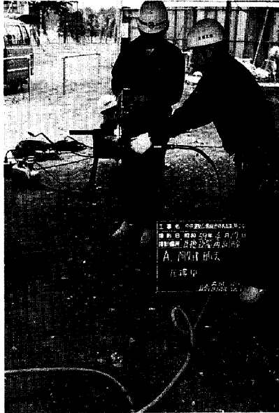
Photo 1 圧接の試験中
