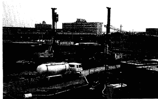
Photo 1 ベースマシンとモルタルプラント
