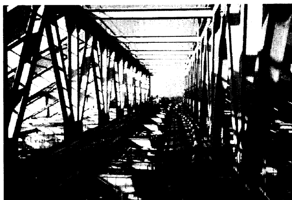
Photo 3 MT梁の完成
