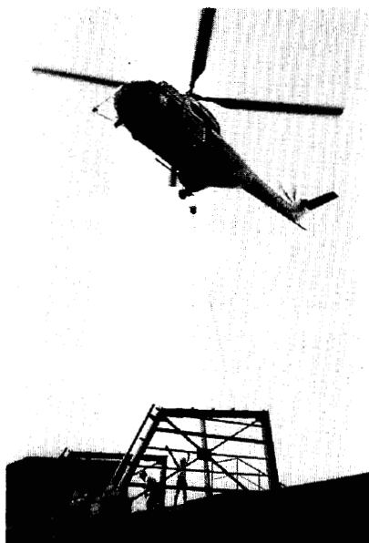
Photo 4 本体鉄骨取付
